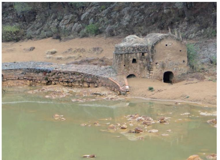
Die Mühle an der alten Brücke über den Río Odiel in Sotiel Coronada. Das Wasser strömte, durch einen künstlich angelegten Damm geleitet, von Norden in das Gebäude, wo es zwei Mahlwerke antrieb
